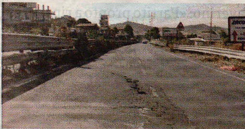
Manto deformato sulla Statale 121
