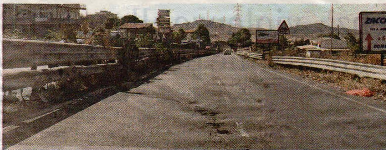
Manto deformato sulla Statale 121
