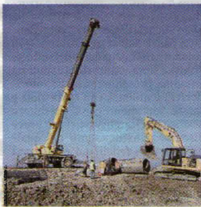
I lavori a una condotta
