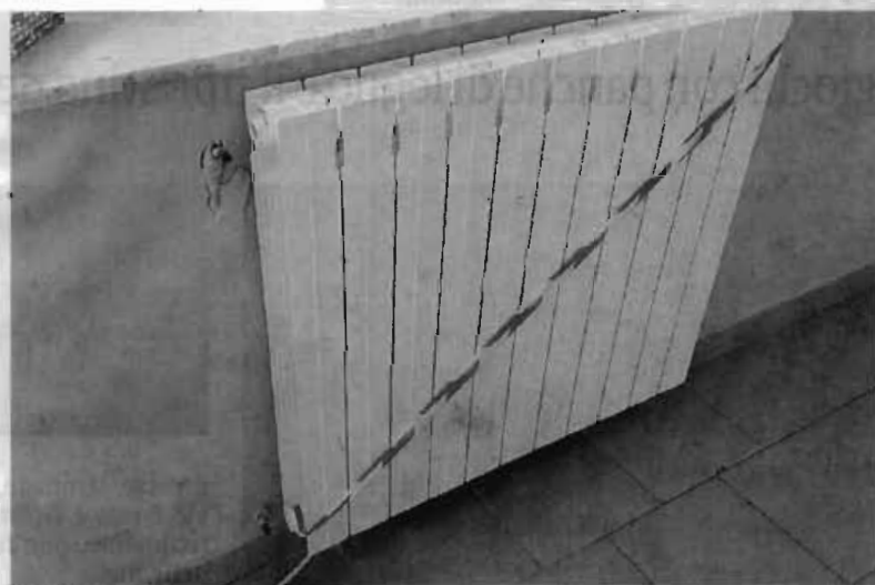
INSTALLATI I RADIATORI NUOVI AL III CIRCOLO DI PATERNÒ
