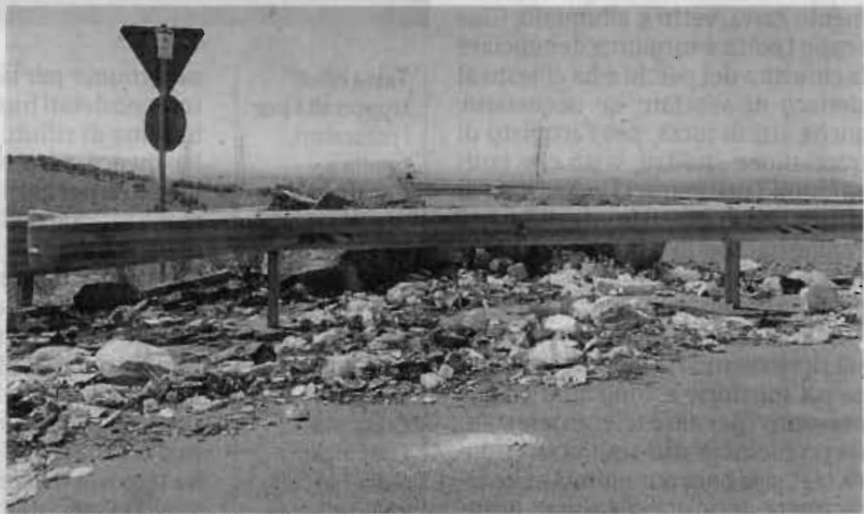
UN TRATTO DELLA ROTONDA SULLA PROVINCIALE 135. A SX L'ASSESSORE GULISANO
